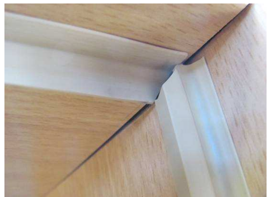
Bild 11 Detail Originaldichtung schließseitig und Überströmdichtung oben
