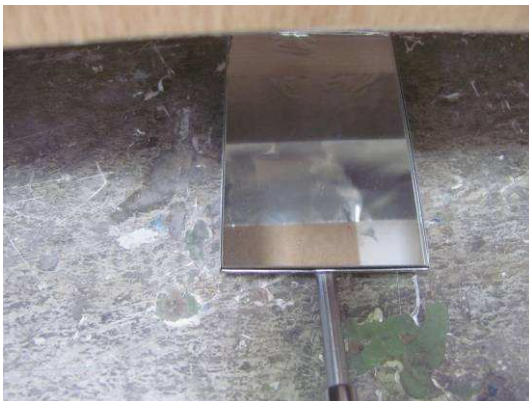
Bild 18 Abdichtung der unteren, horizontalen Fuge mit Aludichtband
