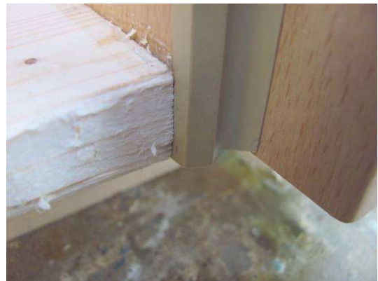
Bild 9 Detail Originaldichtung schließseitig unten
