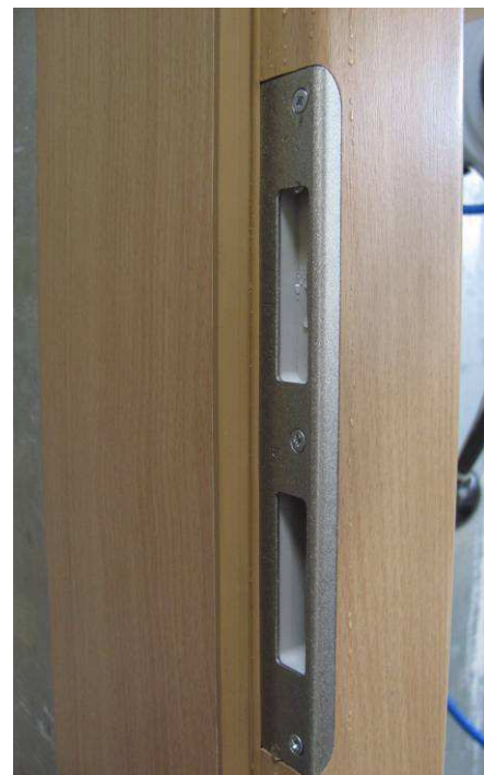
Bild 5 Schließblech Hauptschloss
