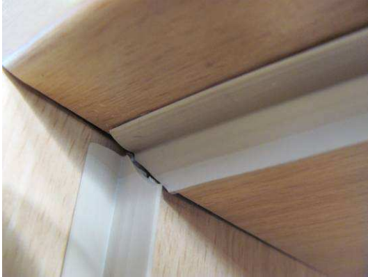
Bild 12 Detail Überströmdichtung bandseitig und Überströmdichtung oben
