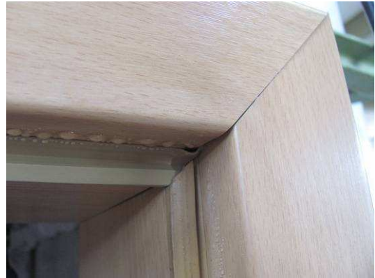
Bild 7 Detail Eckausbildung Originaldichtung schließseitig oben
