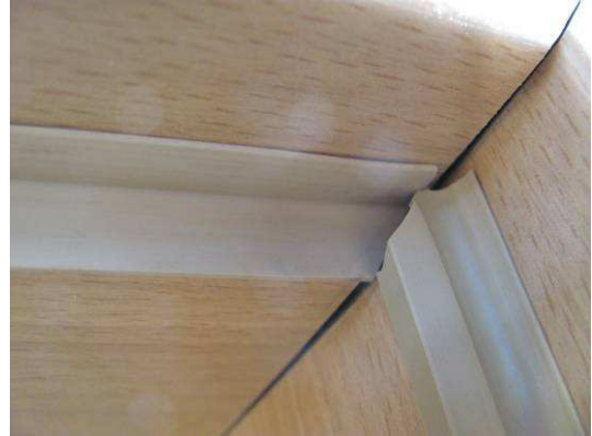
Bild 13 Detail Originaldichtung schließseitig und Überströmdichtung oben
