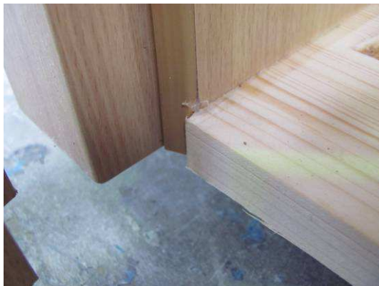
Bild 8 Detail Originaldichtung bandseitig unten
