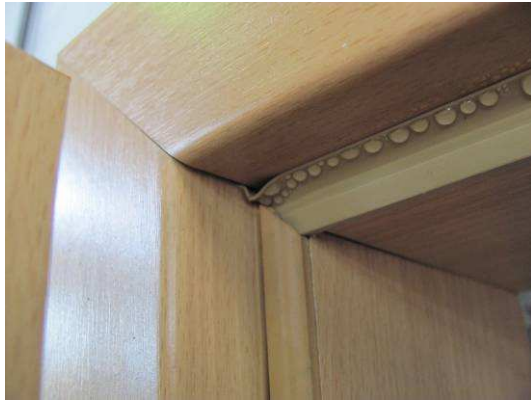
Bild 6 Detail Eckausbildung Originaldichtung bandseitig oben
