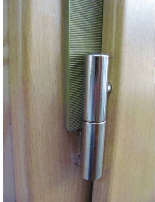
Bild 17 Spaltmaß bandseitig 4 mm
