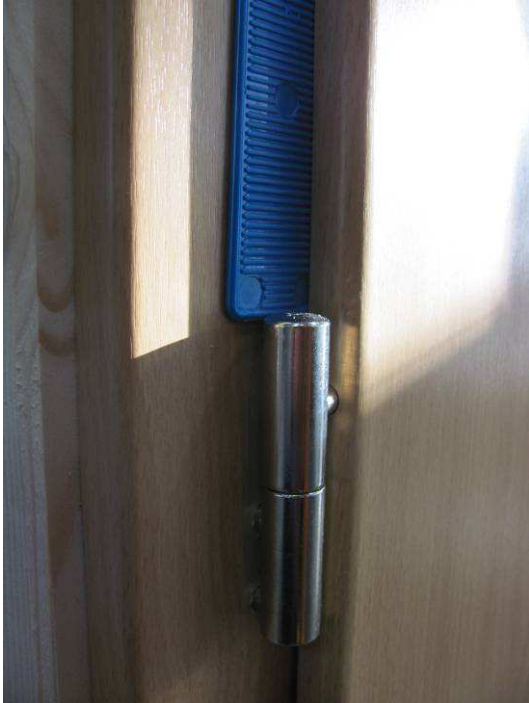
Bild 16 Spaltmaß bandseitig 2 mm
